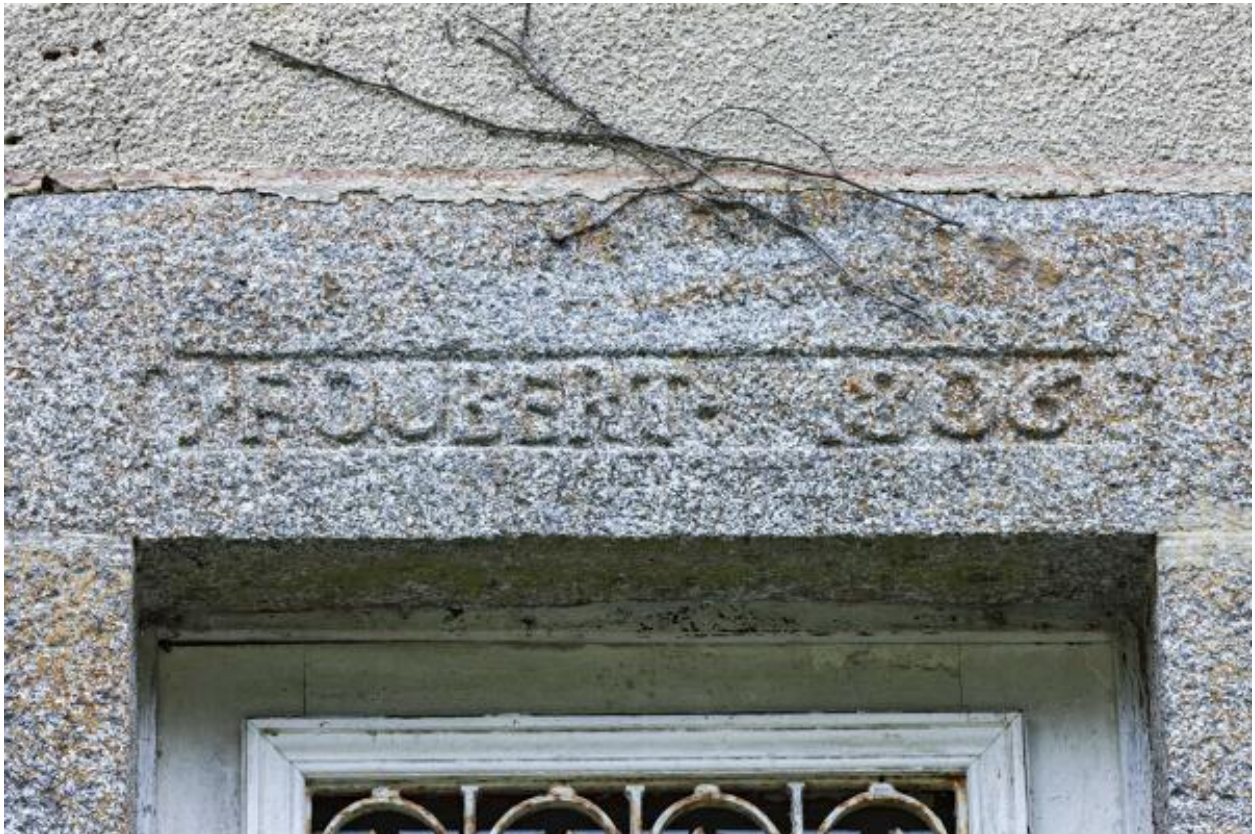
Linteau de porte de la maison, portant l'inscription "I. FOUBERT 1806"
