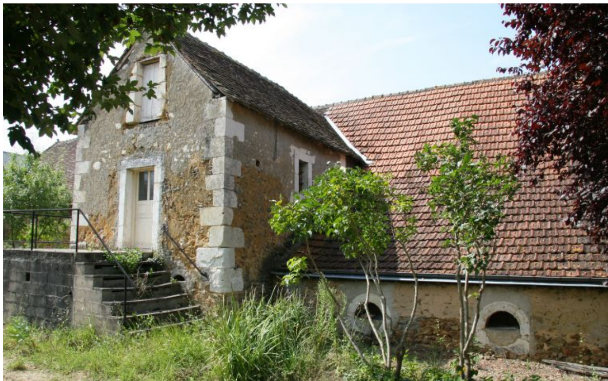
Les communs, corps central : façade postérieure.
