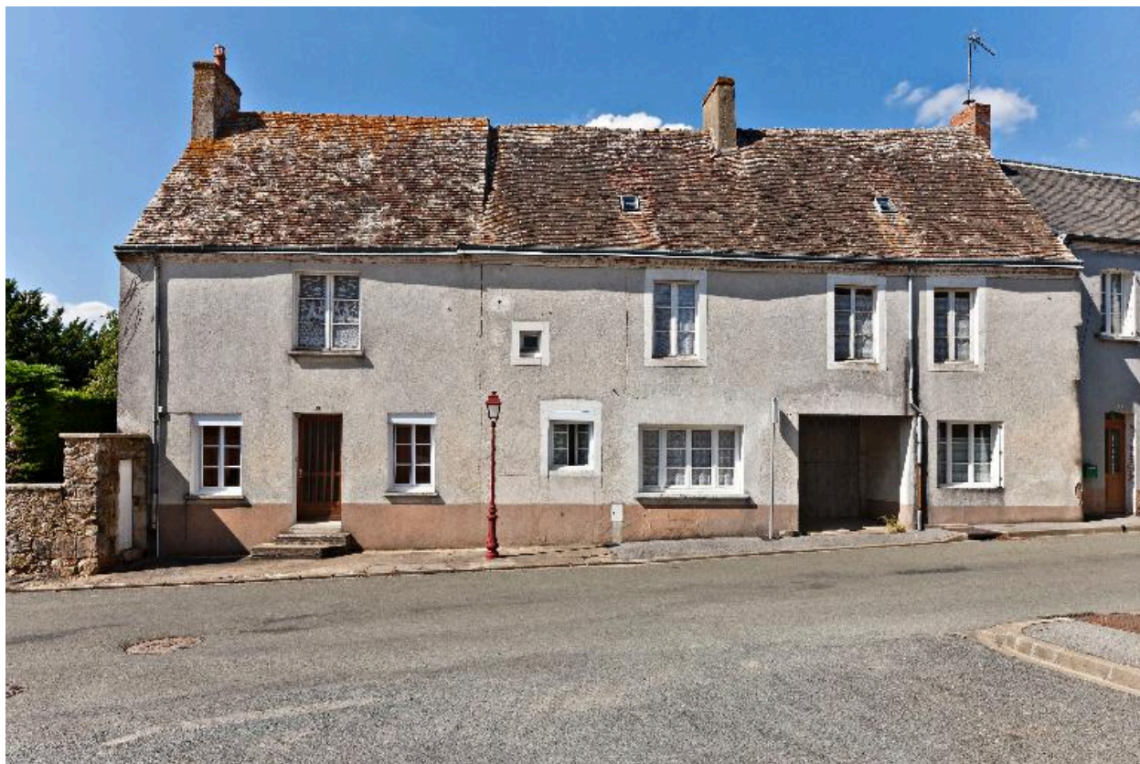
Elévation sur la rue du corps principal.
