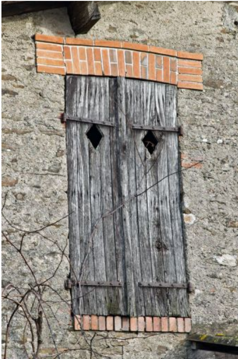
Baie à encadrement de brique, fin 19e-début 20e siècles. (La Hautière)
