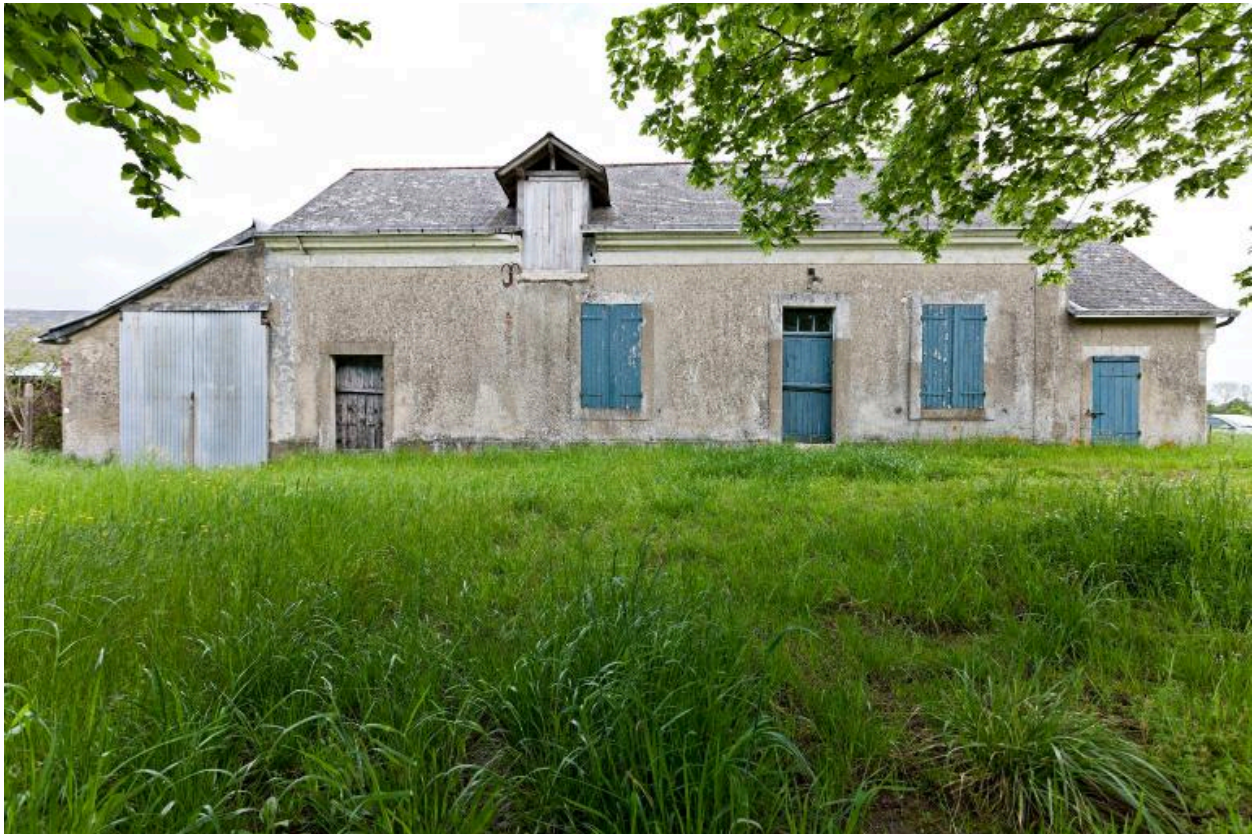
Ferme, façade antérieure.
