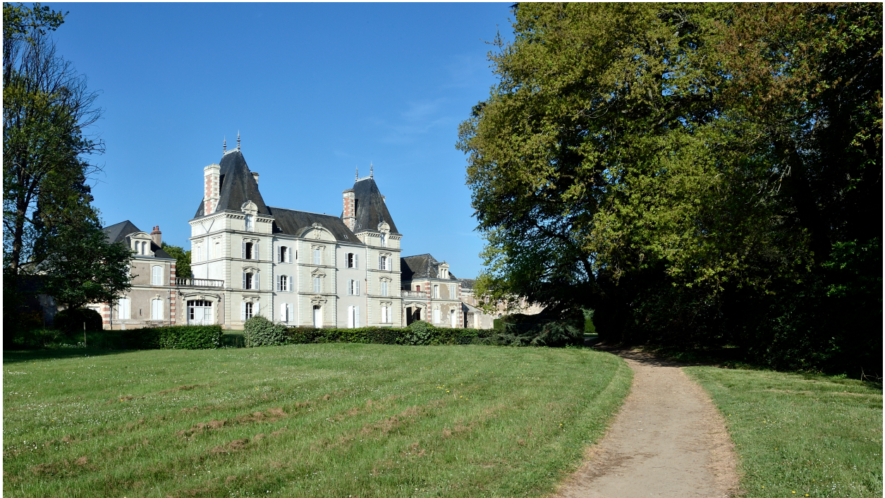
Vue sur la façade arrière du château, depuis le jardin.
