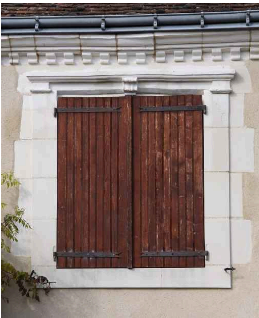
Façade antérieure sur rue, détail : vestiges d'une croisée de la Première Renaissance.
