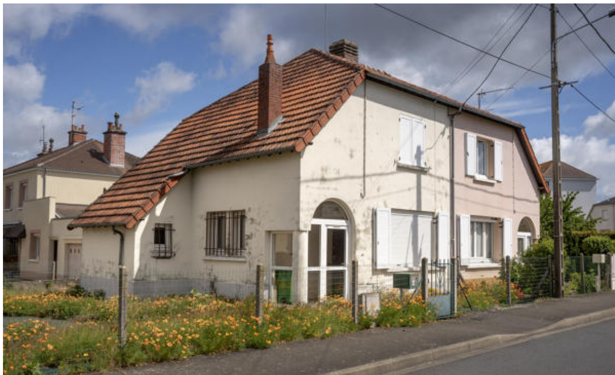
Vue de pavillons doubles pour ouvriers.
