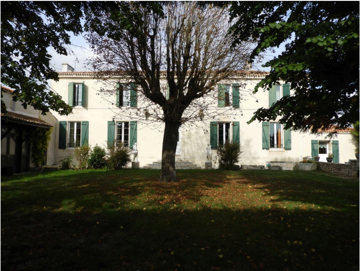
Le logis vu depuis le sud.
