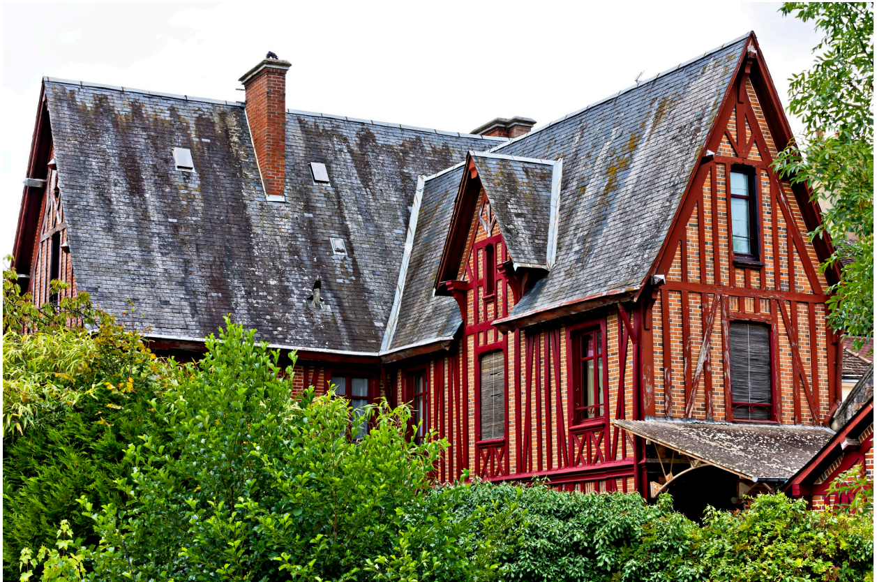
Vue des élévations postérieures.
