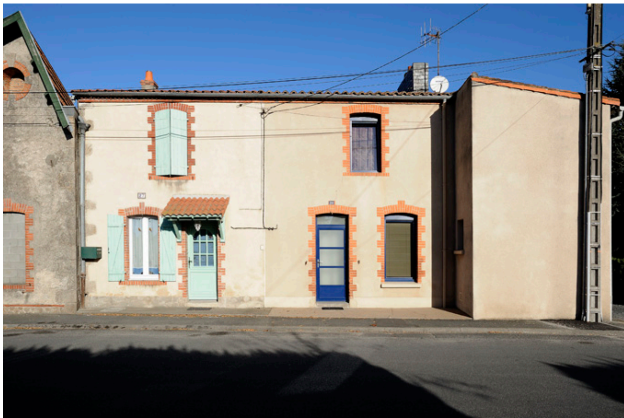
Maisons situées au 27 et au 29 rue Griffon.
