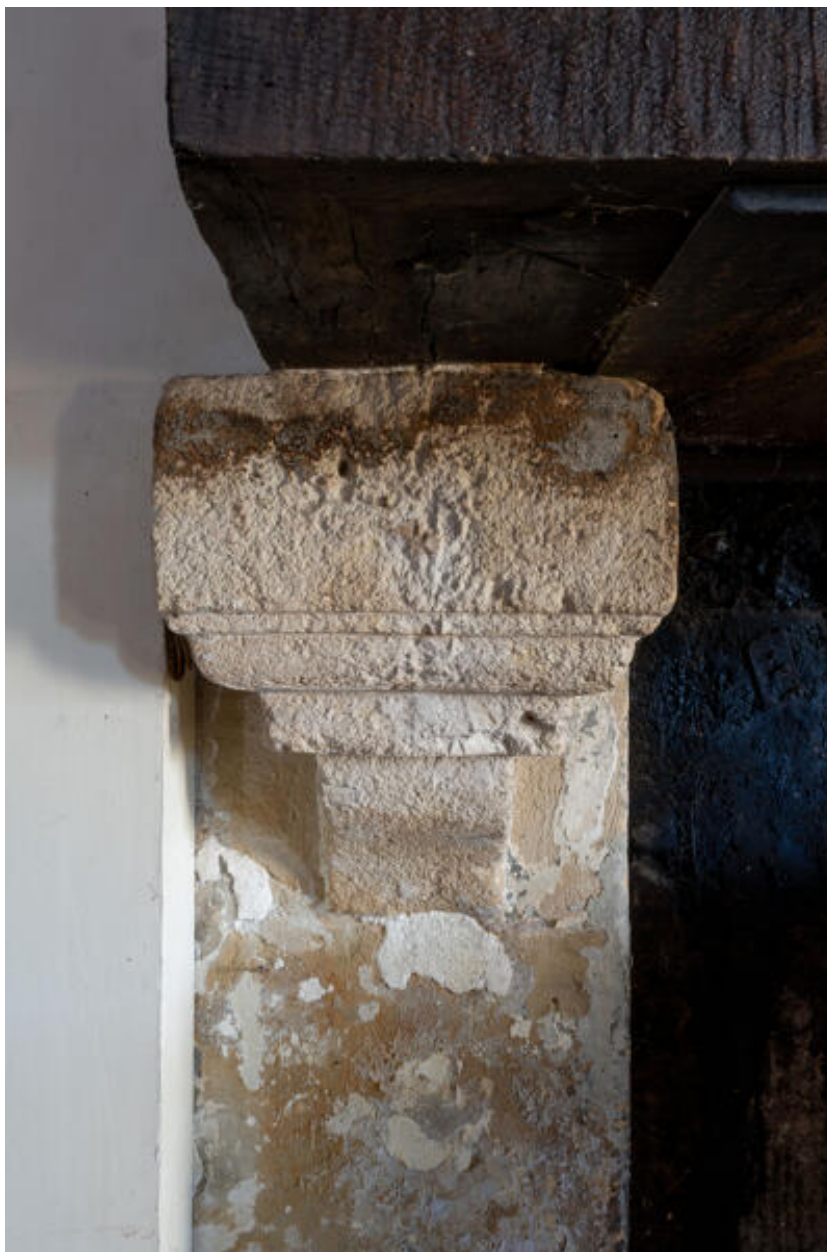
Ferme est, logis, cheminée : détail de console.
