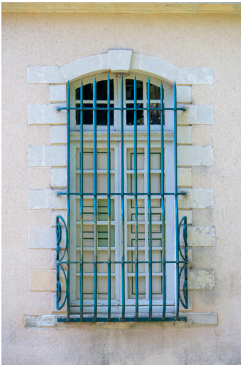
L'aile nord, une fenêtre.
