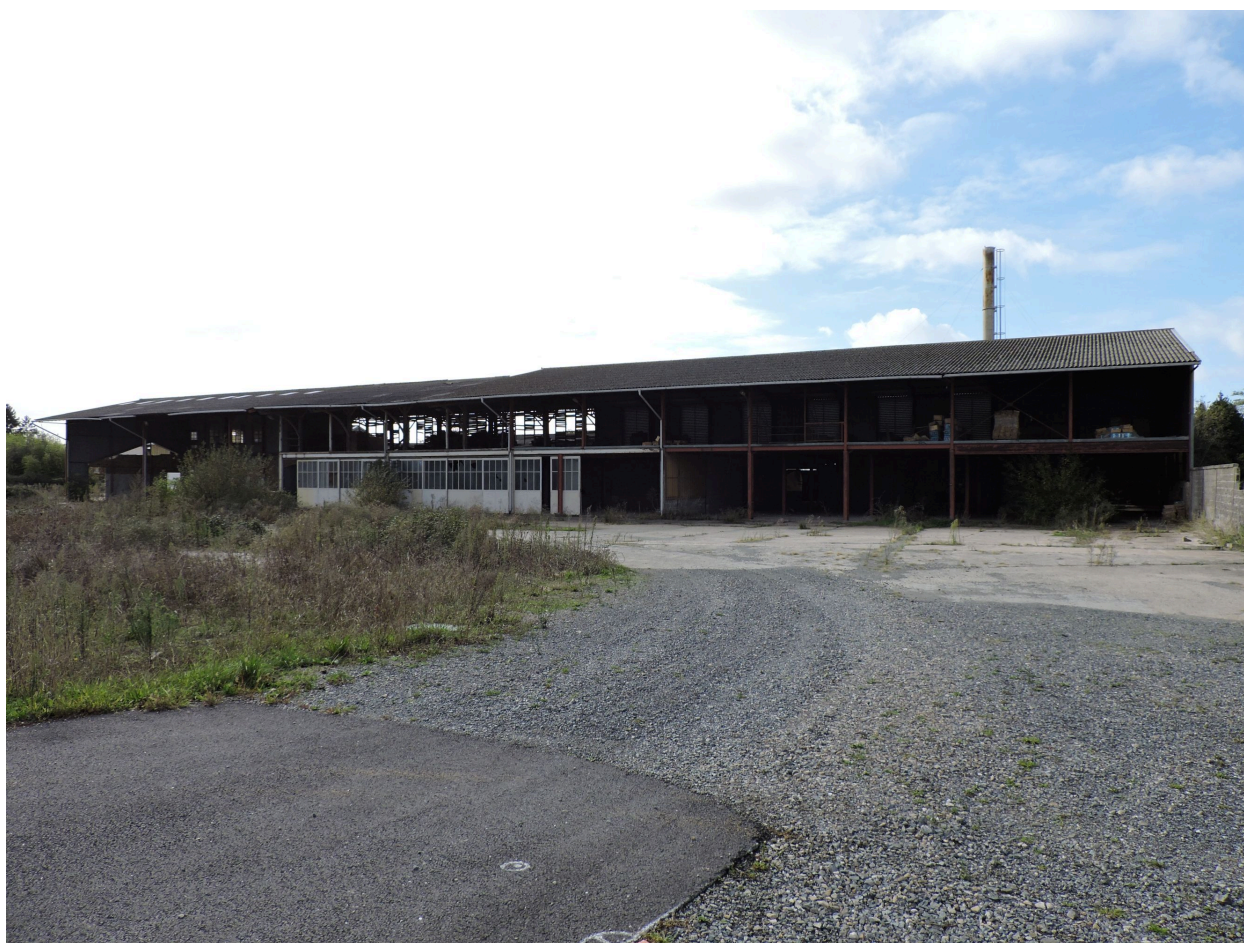
L'ancienne scierie, hangars ouest, vue depuis le nord-est.
