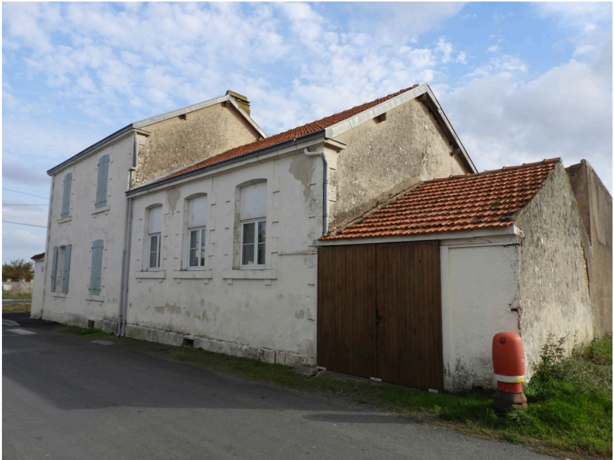
La salle de classe, au nord-ouest de la cour, vue depuis le nord-ouest, côté rue.
