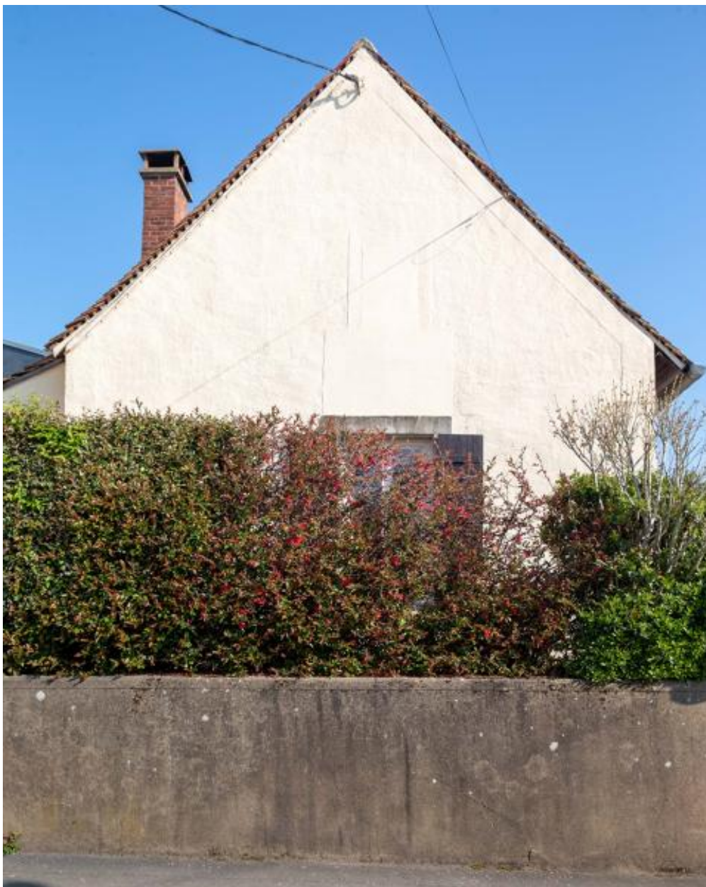
Vue du pignon de l'ancien corps de ferme rue du Pavé.
