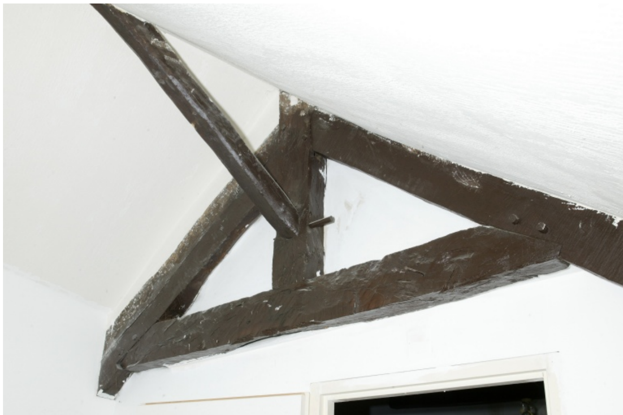
Détail d'une ferme de charpente.
