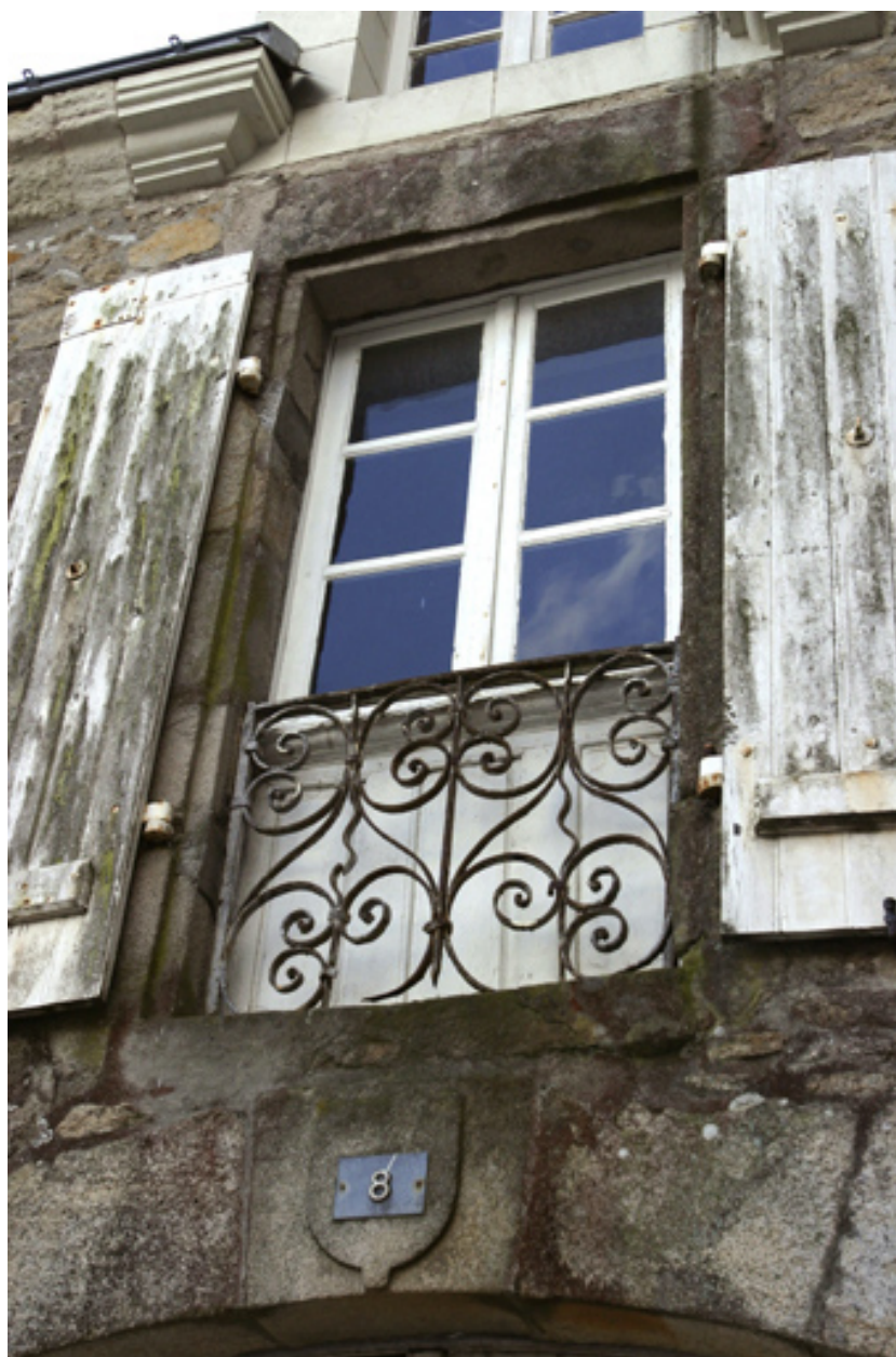
Fenêtre et garde-corps en ferronnerie de la façade sur rue de l'aile est.
