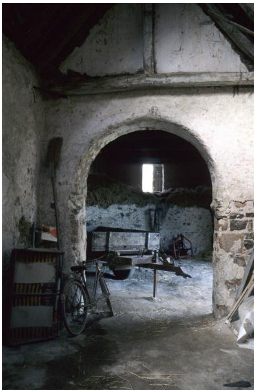
Choeur, mur ouest : rinceaux partiellement badigeonnés, état avant travaux. Photographie de Jean Moreau, fin des années 1980.
