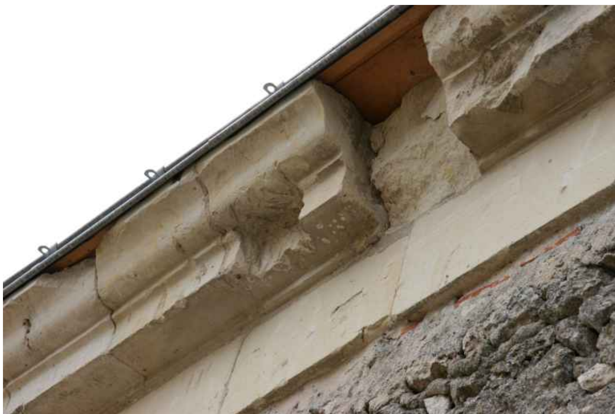
Aile ancienne : corniche.
