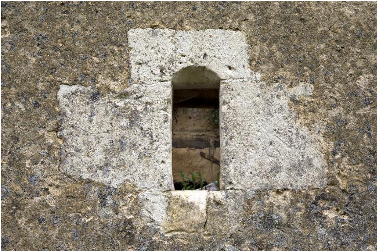
Ferme en ruines (n°5) : petite ouverture en façade principale (baie d'une étable ?).
