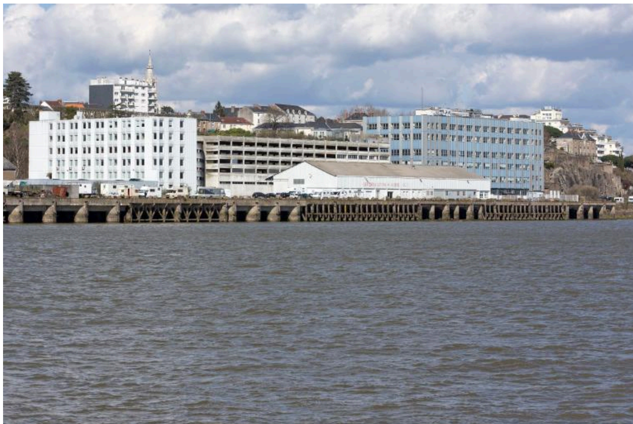
Parking, vue de la Loire.
