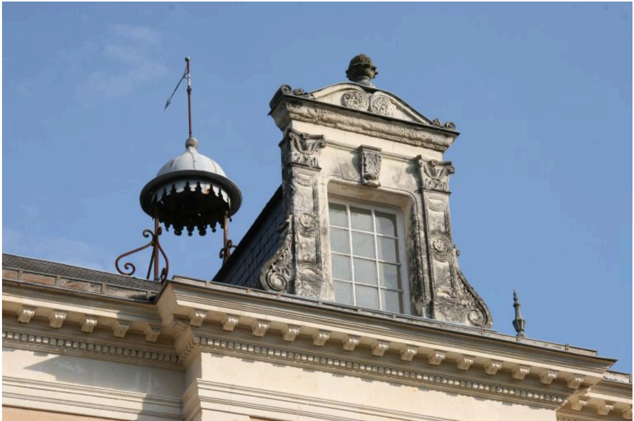
Façade antérieure sur cour : lucarne centrale.
