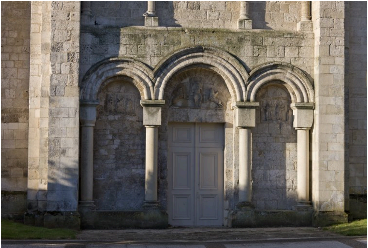
Façade du bras nord du transept : niveau inférieur.
