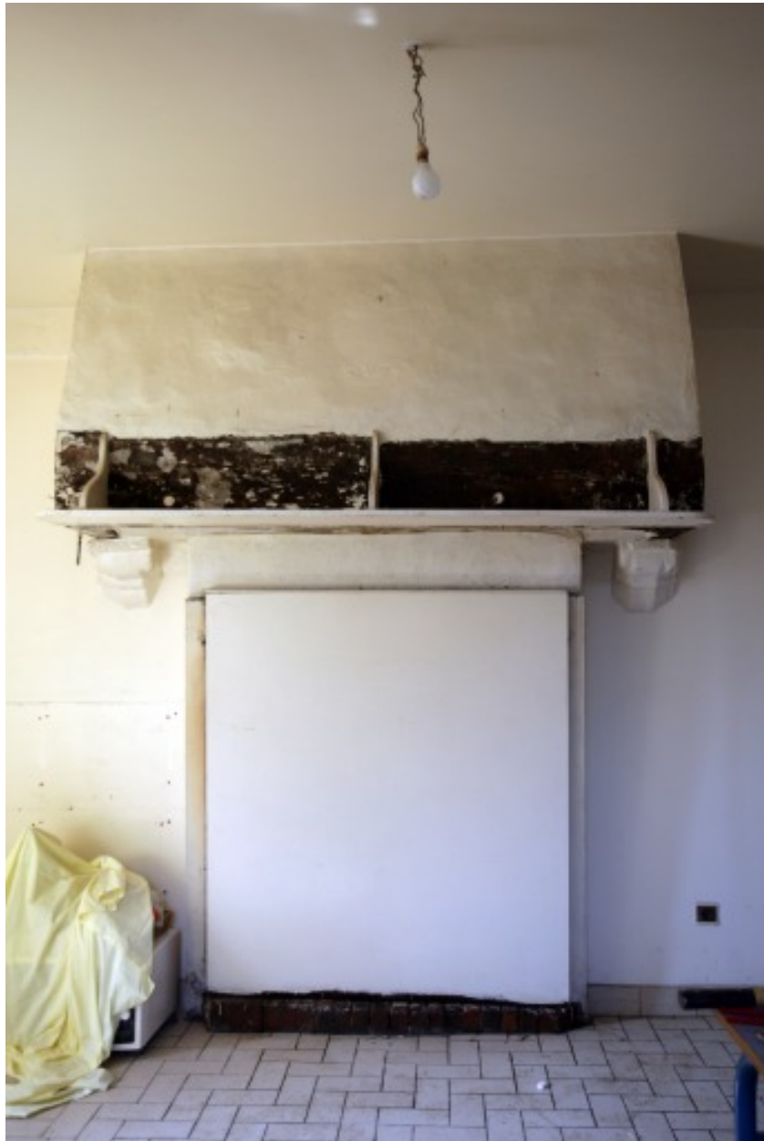
Intérieur du corps nord, premier étage, pièce est : la cheminée vue depuis l'est, après dégagement des corbeaux..
