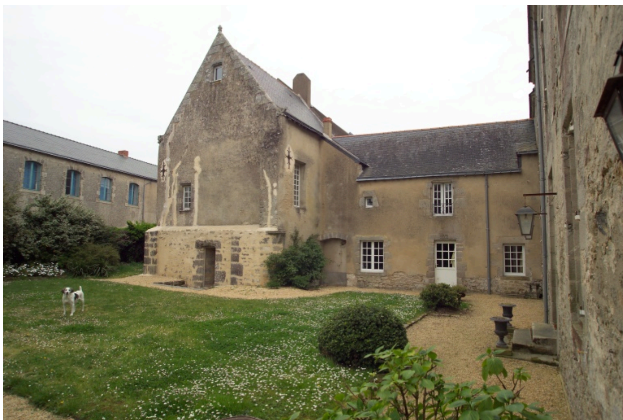
Vue générale vers le Nord-Est.
