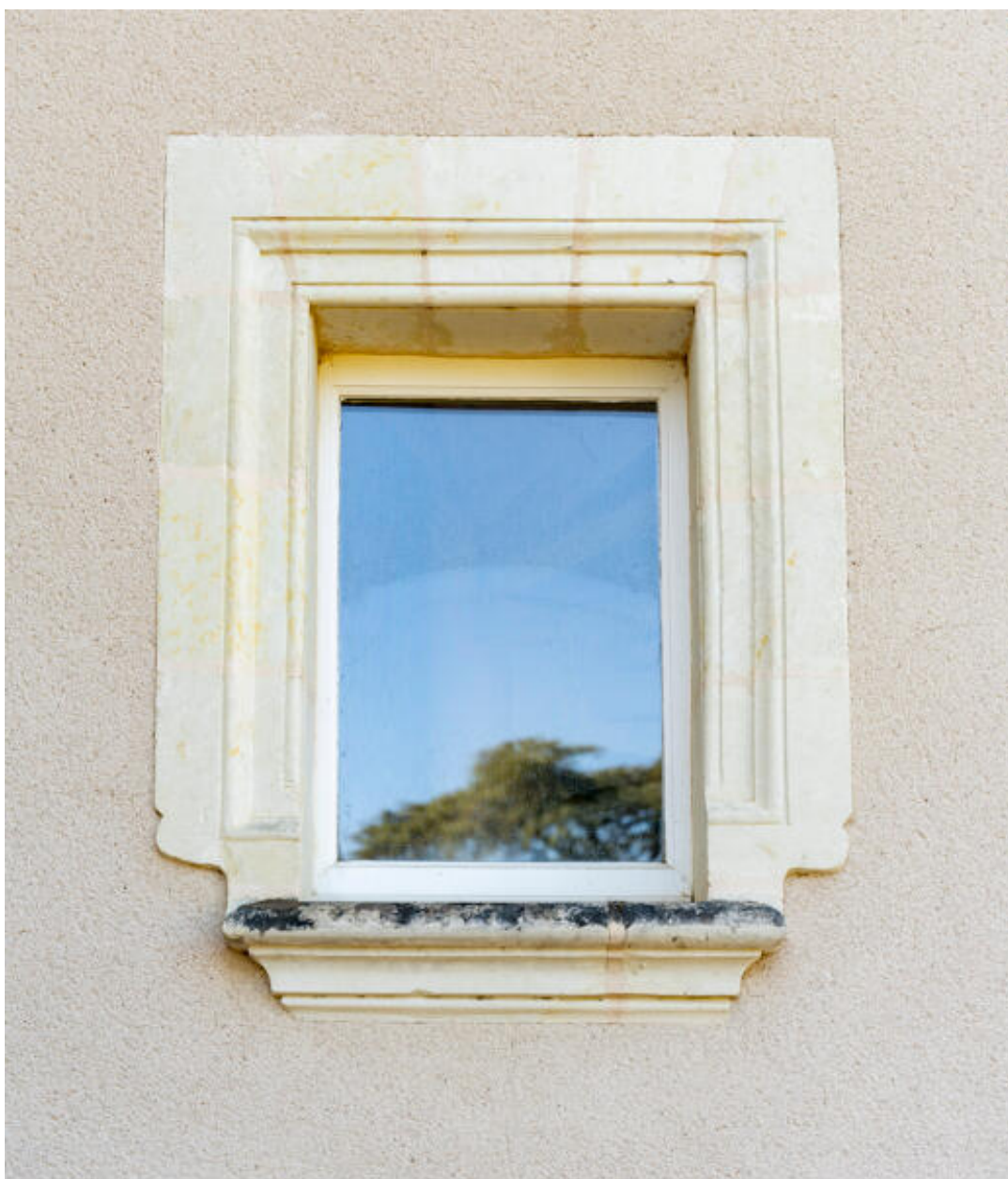
Une fenêtre de la tourelle d'escalier.
