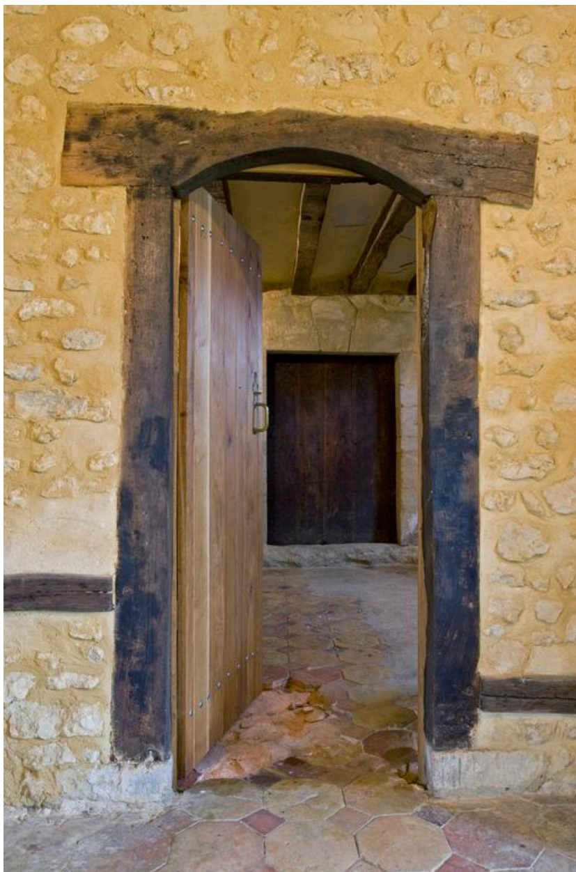
Porte de communication entre la pièce à feu et la pièce froide.
