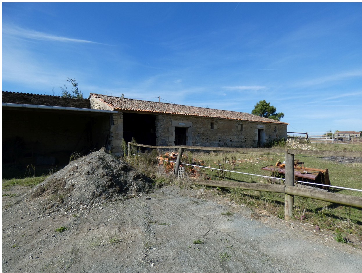
Hangar et étable au nord de l'ensemble, vus depuis le sud-est.
