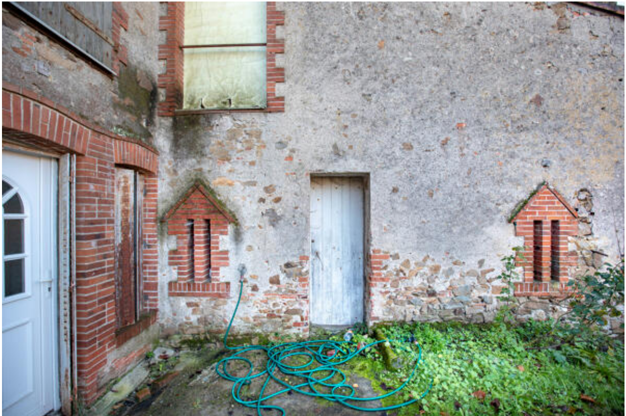
Détails des baies en archère.
