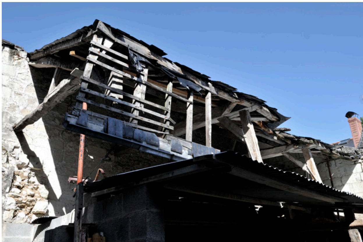
Ancien chaix (ruiné) : vestiges de la toiture en appentis mansardé
