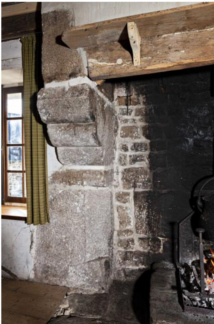
Logis sud, cheminée du mur-pignon sud.
