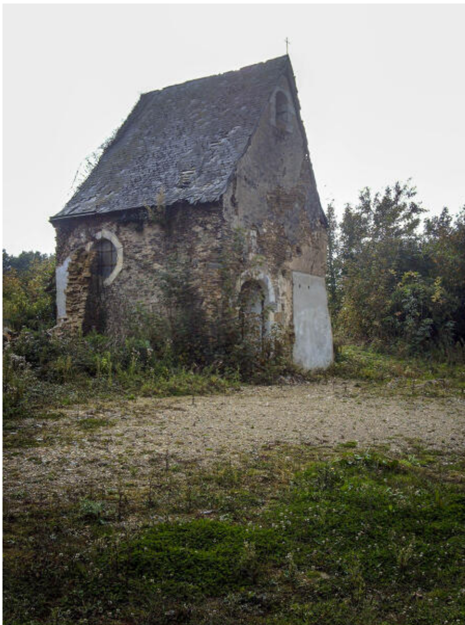
La chapelle peu avant sa démolition en 2015 (cliché SAHM).
