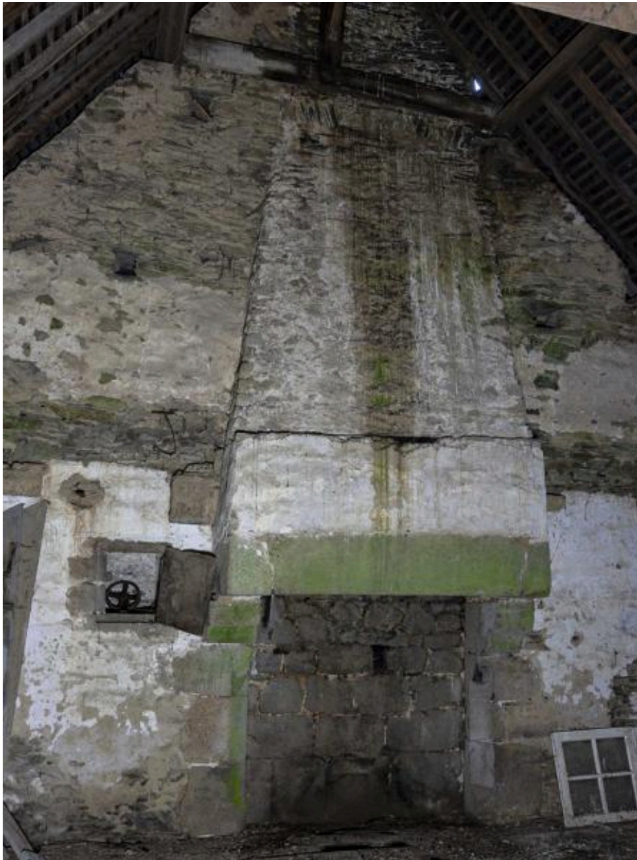
Corps de logis sud, logis nord, cheminée du mur-pignon nord.
