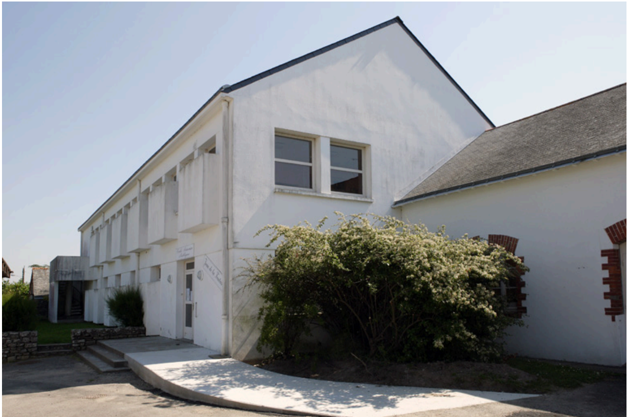
Vue de la façade ouest et de l'extension depuis le sud-ouest.
