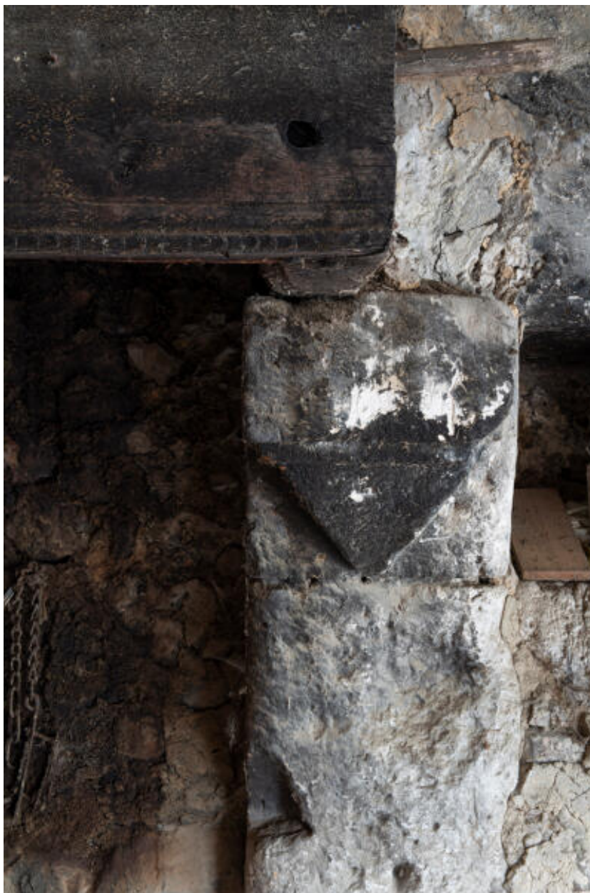
Ancien logis de la ferme des Guénardières, actuellement garage (cadastre 2024 C 247) : détail de la cheminée.
