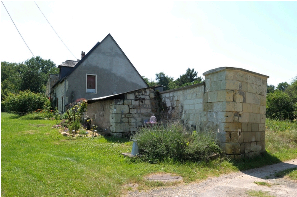
Vue de l'habitation actuelle et vestiges de l'ancienne clôture du manoir.
