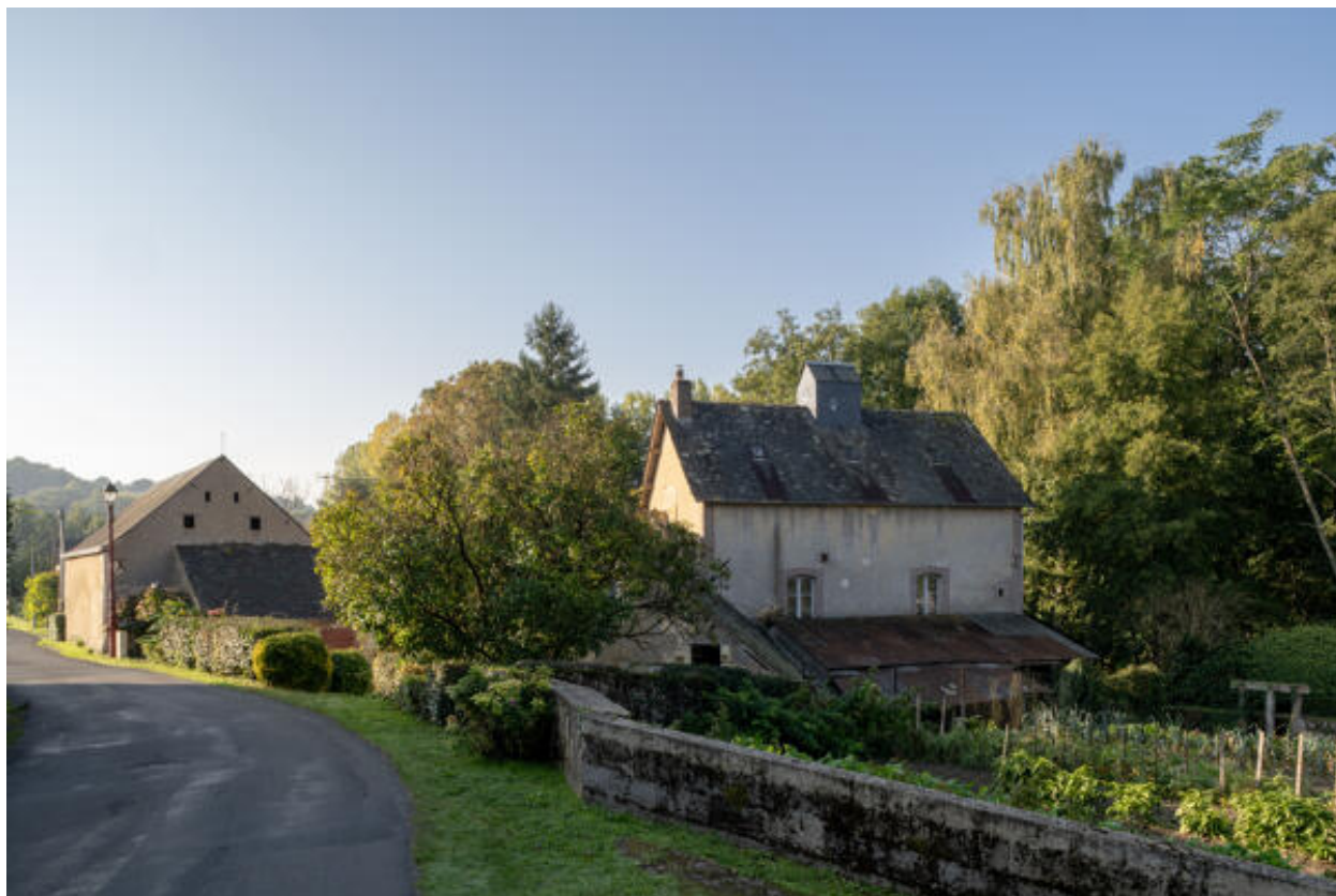
Vue d'ensemble depuis le nord, rue du Moulin.
