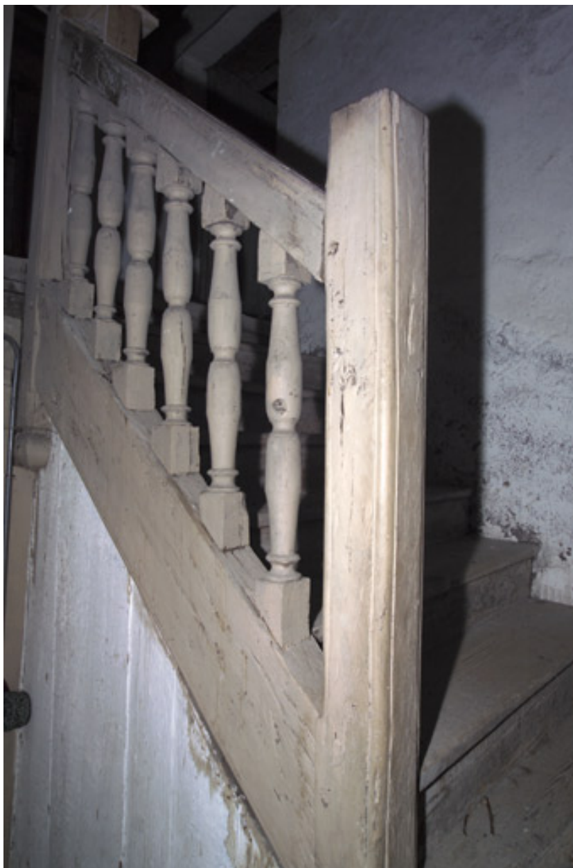
L'escalier, la volée d'accès au niveau du comble.
