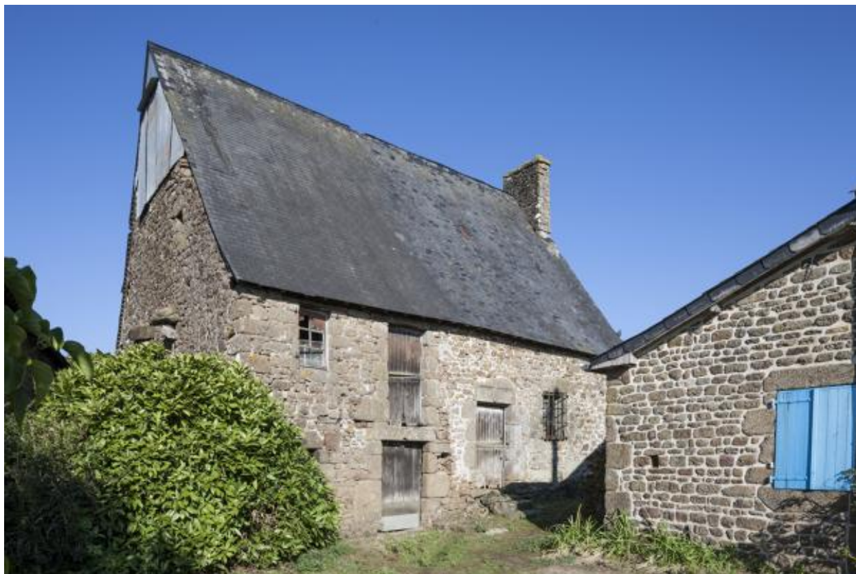
Maison de Bignon, façade orientale.
