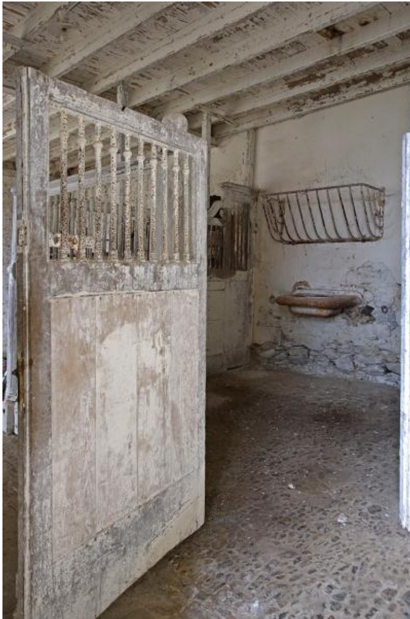
L'aile de communs nord, intérieur de l'écurie.
