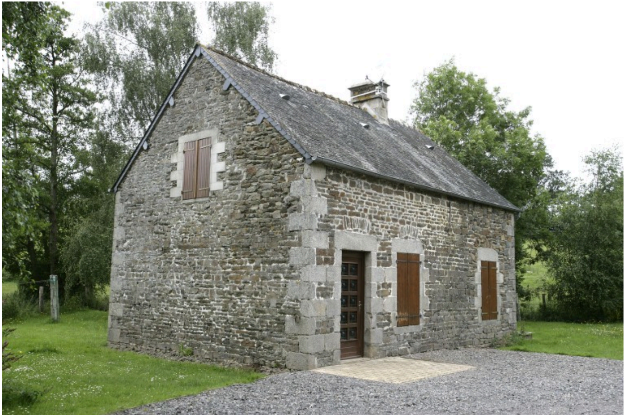
Le logis du meunier vu depuis le sud-est.
