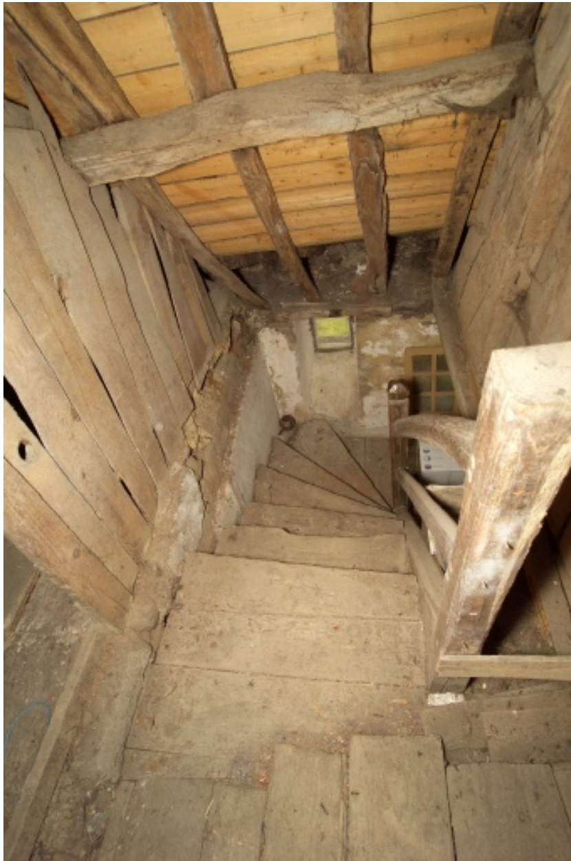
Vue de l'escalier depuis le comble.
