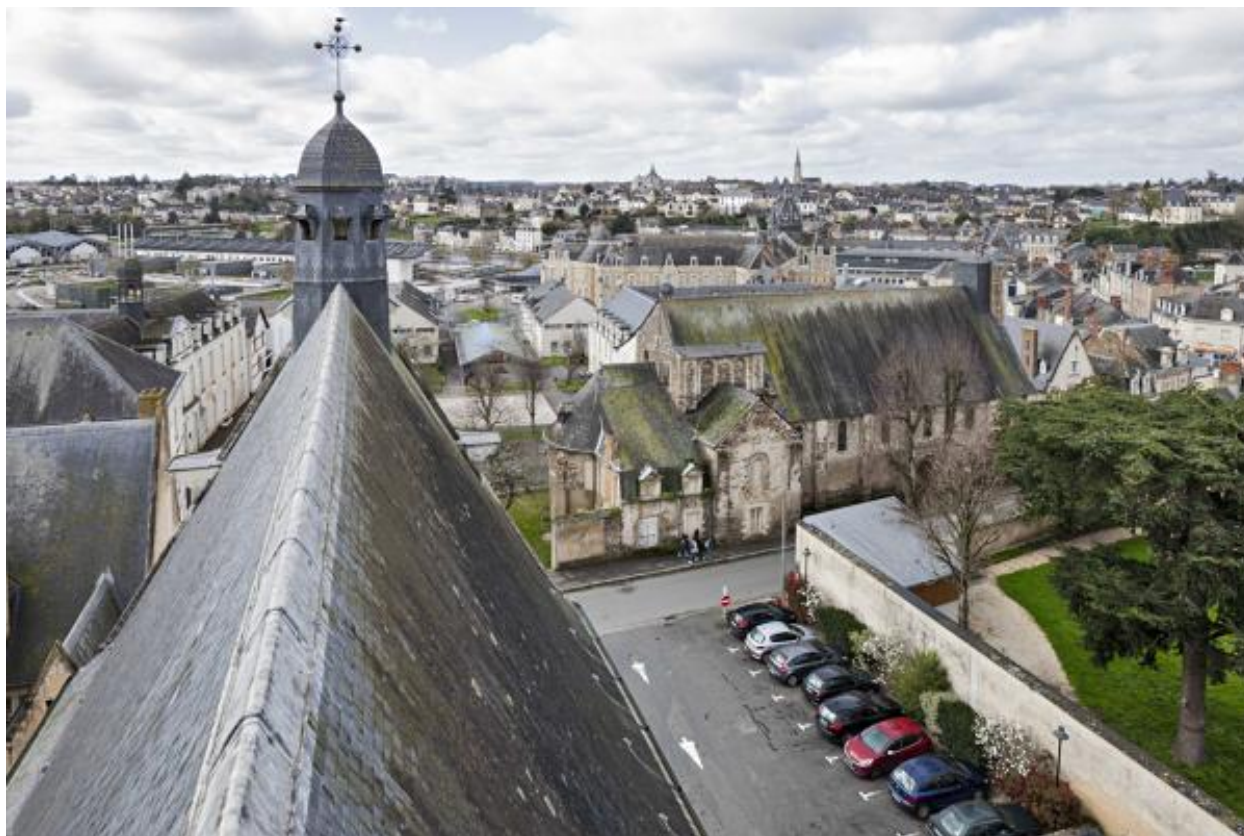
Vue de la couverture de la chapelle des Ursulines et de la chapelle du Genêteil prise depuis le clocheton. Couvent des Ursulines de Château-Gontier
