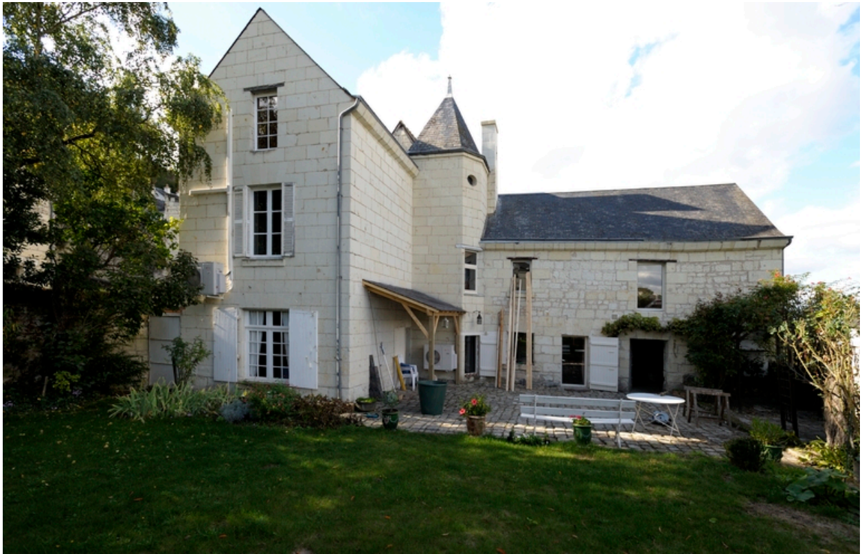
Façades sur cour.
