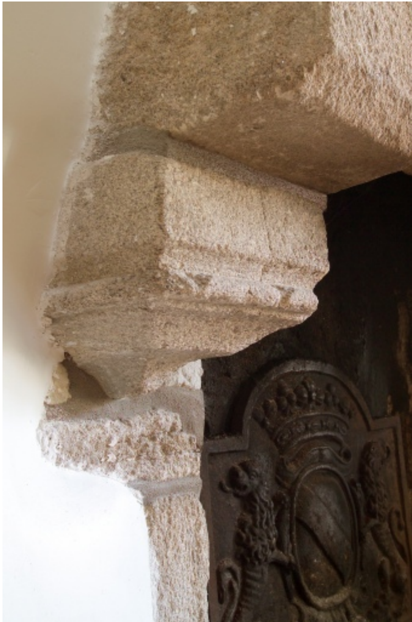
Cheminée du deuxième étage, détail de la console du piédroit gauche.
