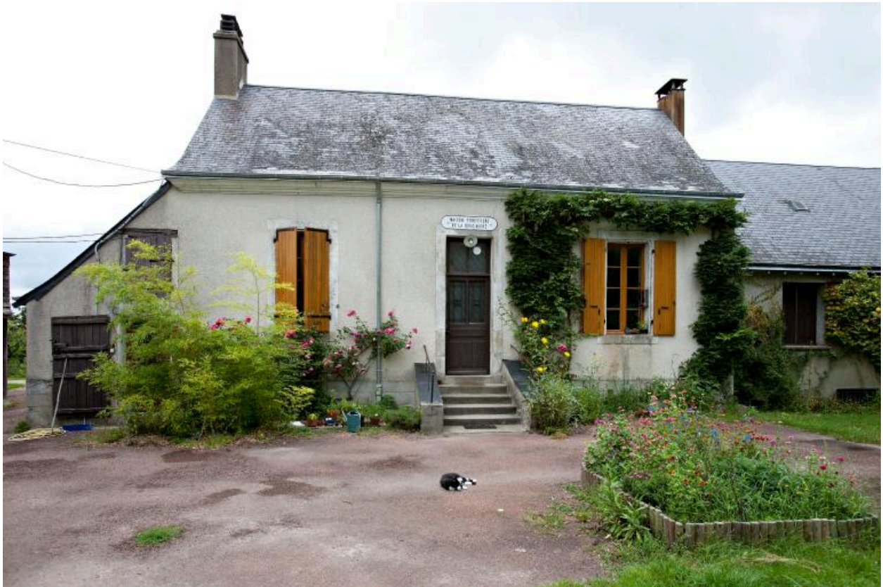
Maison forestière : façade antérieure sur cour.
