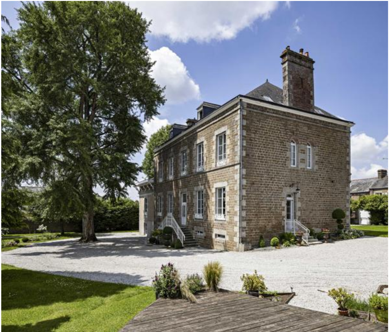
Maison, depuis le nord-est.
