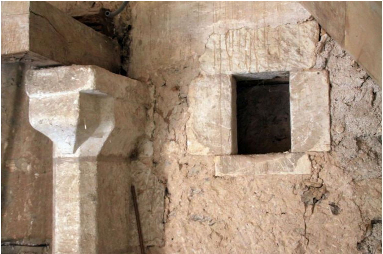
Logis, comble, cheminée : détail du corbeau droit + niche.
