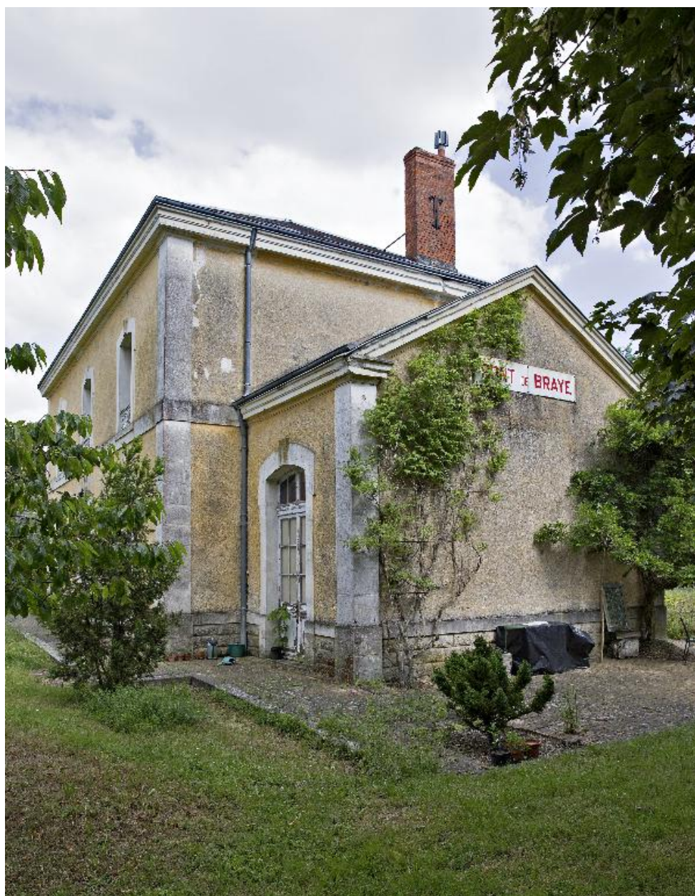
Vue de volume du bâtiment voyageurs côté cour, avec plaque nominative subsistante.
